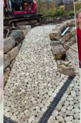
Geländeabstützung mit neuem Terrassenbelag
